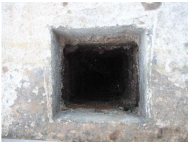
Dimovodni kanal prije proširivanja
