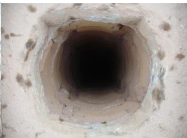
Dimovodni kanal nakon proširivanja
