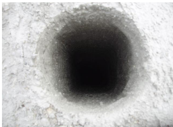
Dimnjak nakon premazivanja- gledano odozgo
