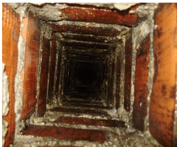
Dimnjak prije premazivanja
