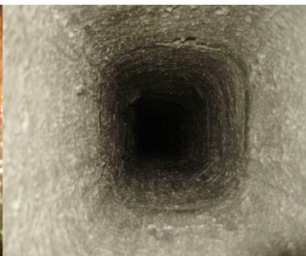
Dimnjak nakon premazivanja- gledano odozdo
